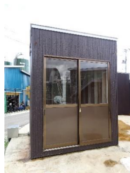
原料槽の攪拌機は、臭気漏れ対策のため、一基ずつ建屋で覆われている。
