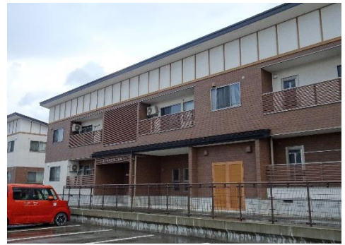
地域熱供給の集合住宅
